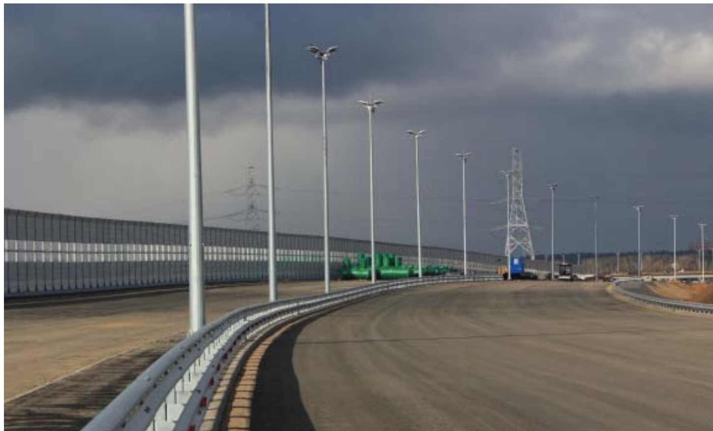
М-8 «Холмогоры». Км 25+200. Обход пос. Тарасовка. Ввод – сентябрь 2015 г.
